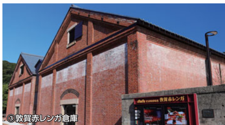
③ 敦賀赤レンガ倉庫
